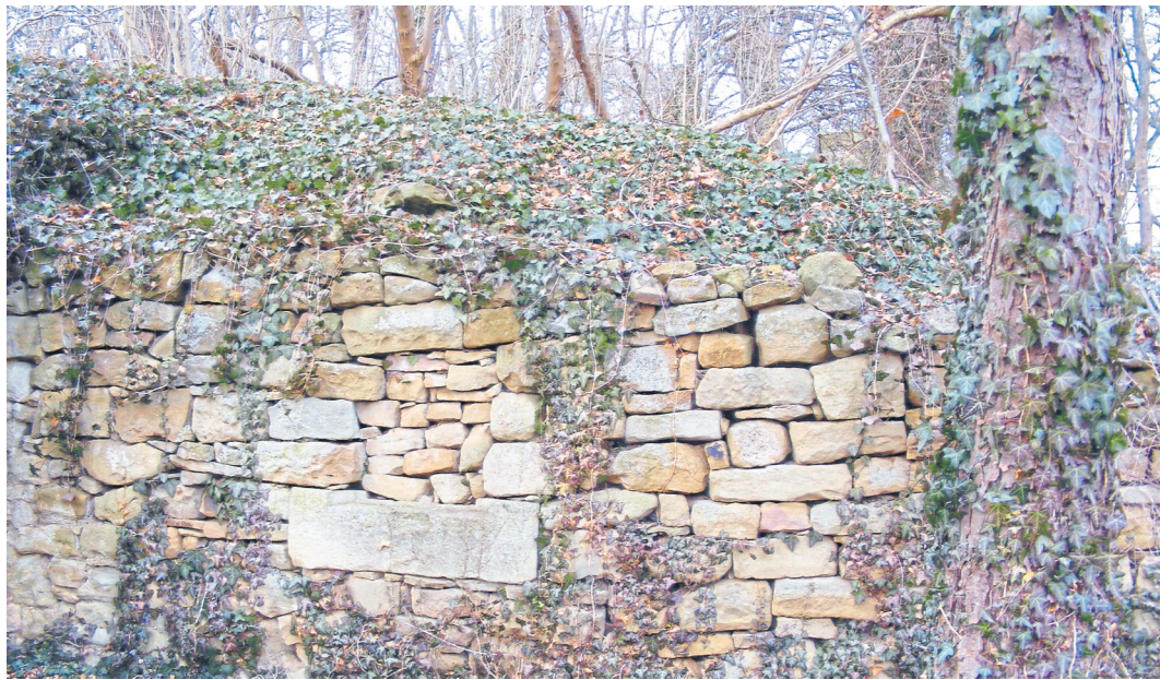
Rest des Fensters auf der Südseite des Wohnturms
