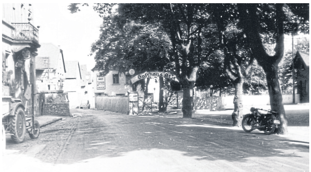
Ortseingang aus Richtung Kirn vor dem Abriss des Gasthauses Arzt.
