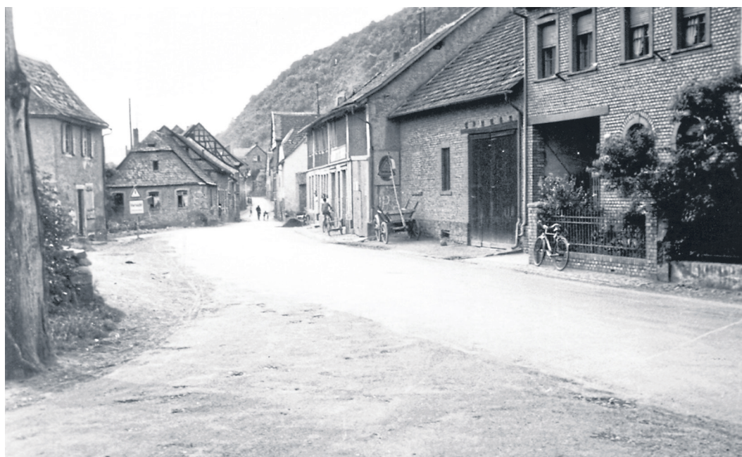
Ortseingang aus Richtung Sobernheim vor dem Abriss der Häuser.
